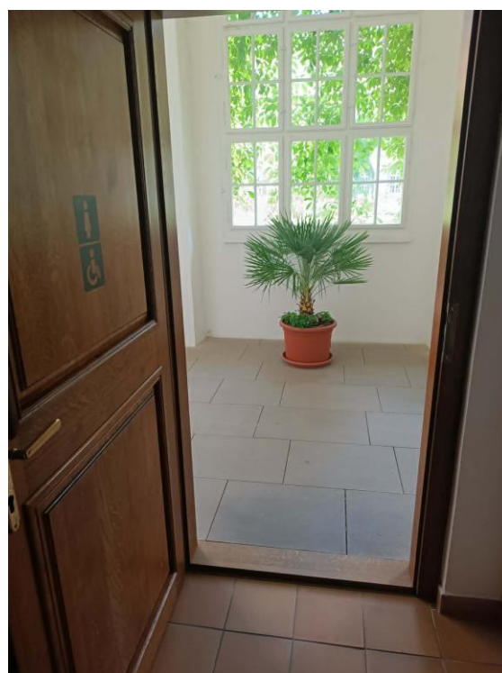
Nízký práh u vstupu na toalety
